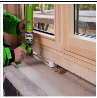
1. Bild: Verarbeitung der Fensteranschlussfuge mit FM220.
